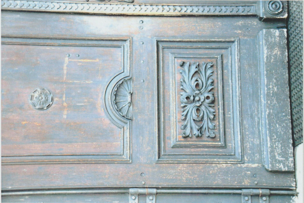
5. Drzwi wejściowe (główne) do kościoła parafialnego w LUSZOWICACH (1913-1916r.)
