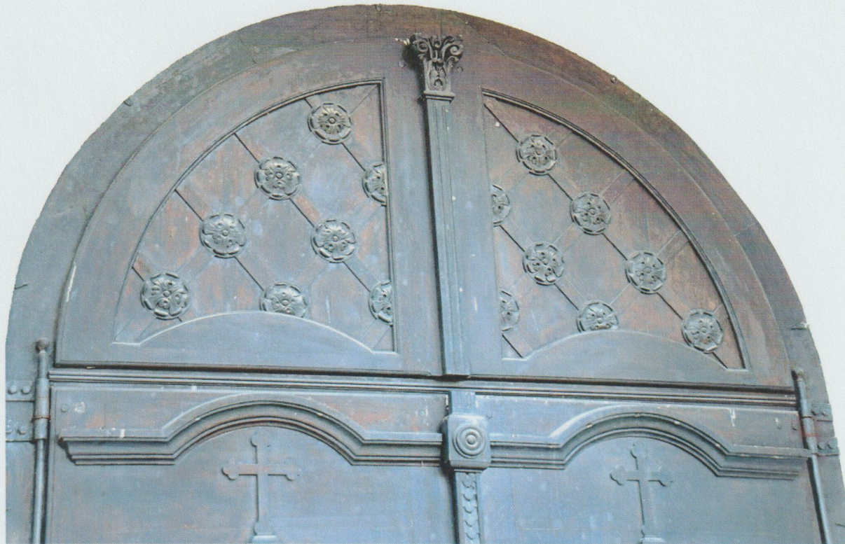
2. Drzwi wejściowe (główne) do kościoła parafialnego w LUSZOWICACH (1913-1919r.)
