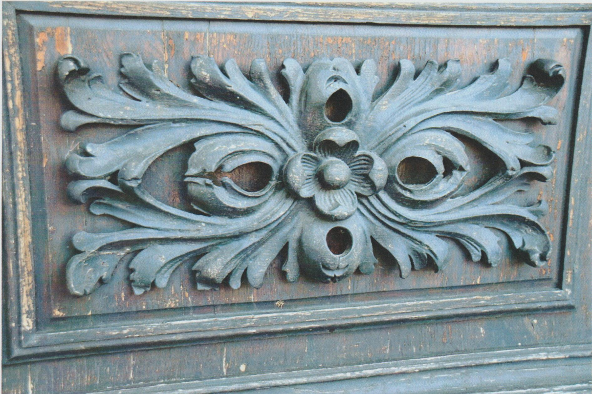
9. Drzwi wejściowe (główne) do kościoła parafialnego w LUSZOWICACH (1913-1916r.)
