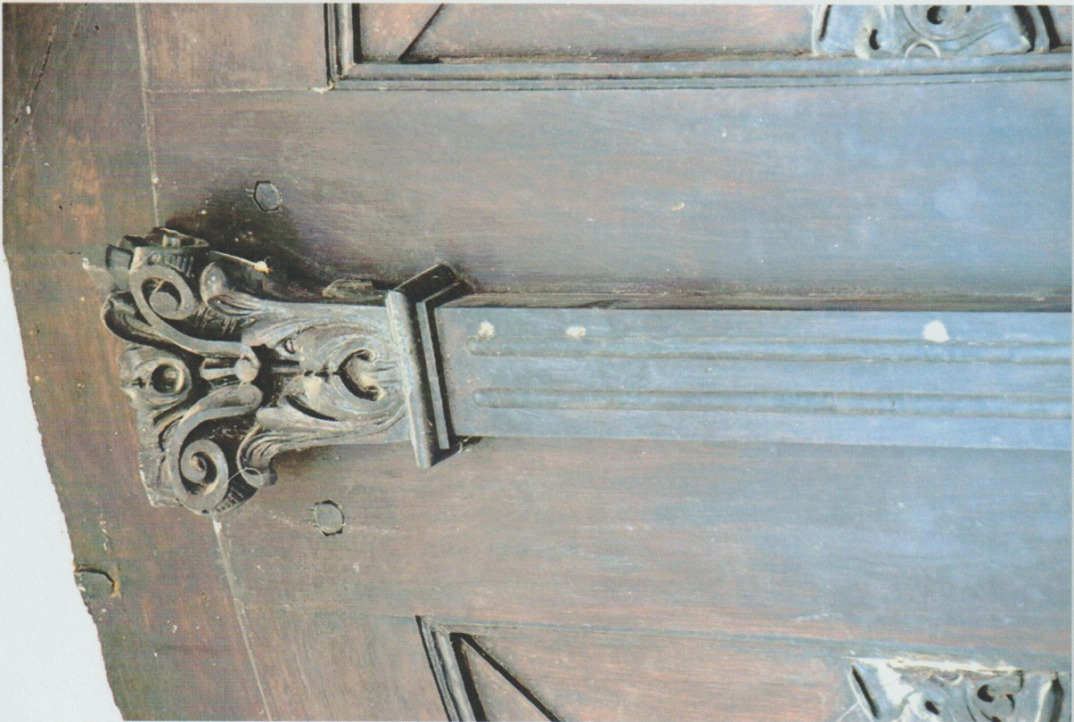
7. Drzwi wejściowe (główne) do kościoła parafialnego w LUSZOWICACH (1913-1916r.)
