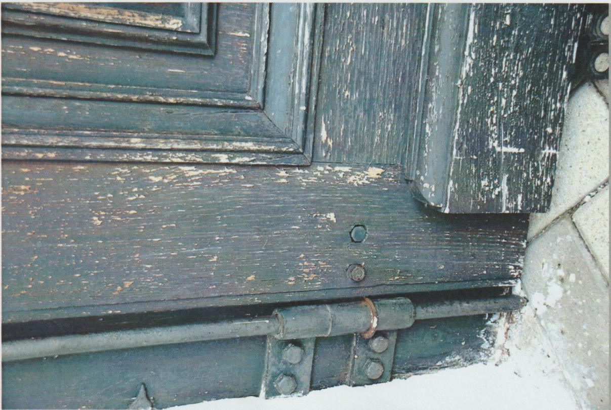
15. Drzwi wejściowe (główne) do kościoła parafialnego w LUSZOWICACH (1913-1916r.)
