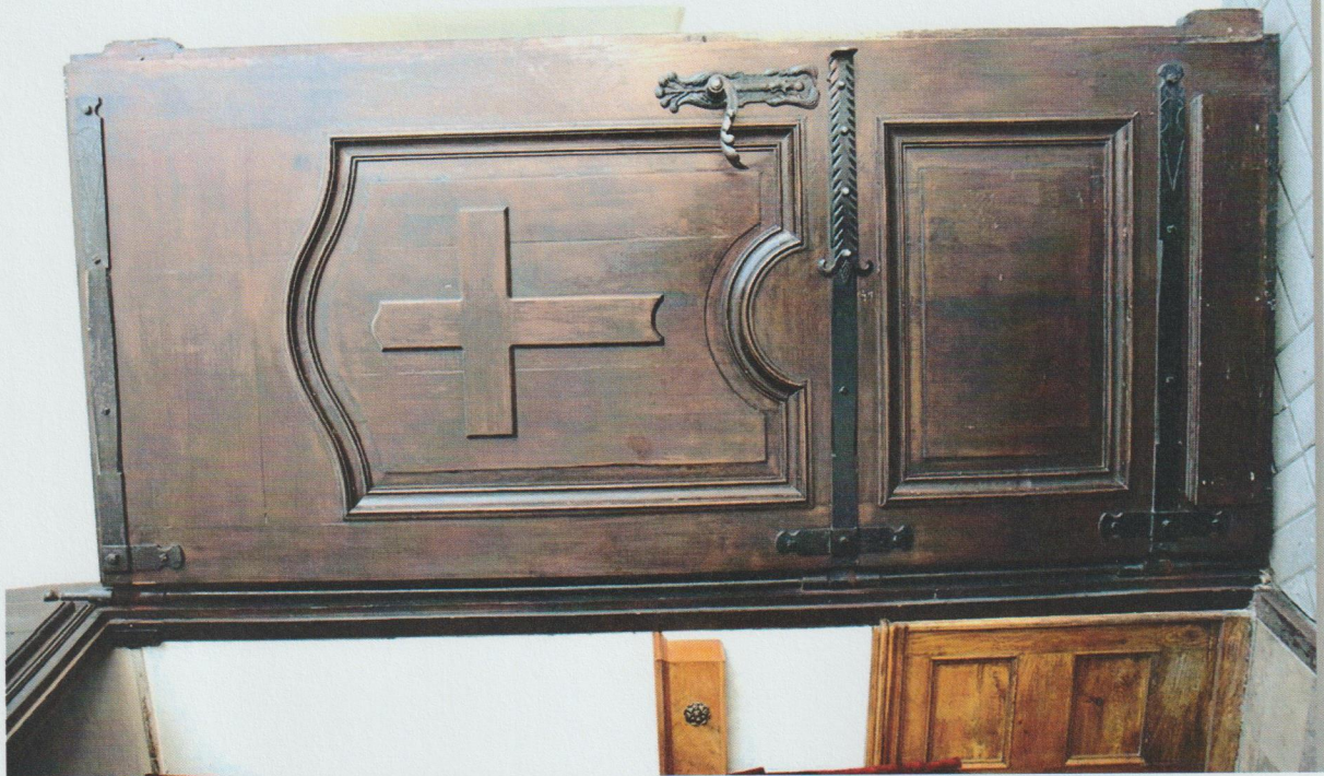
10. Drzwi wejściowe (główne) do kościoła parafialnego w LUSZOWICACH (1913-1916r.)
