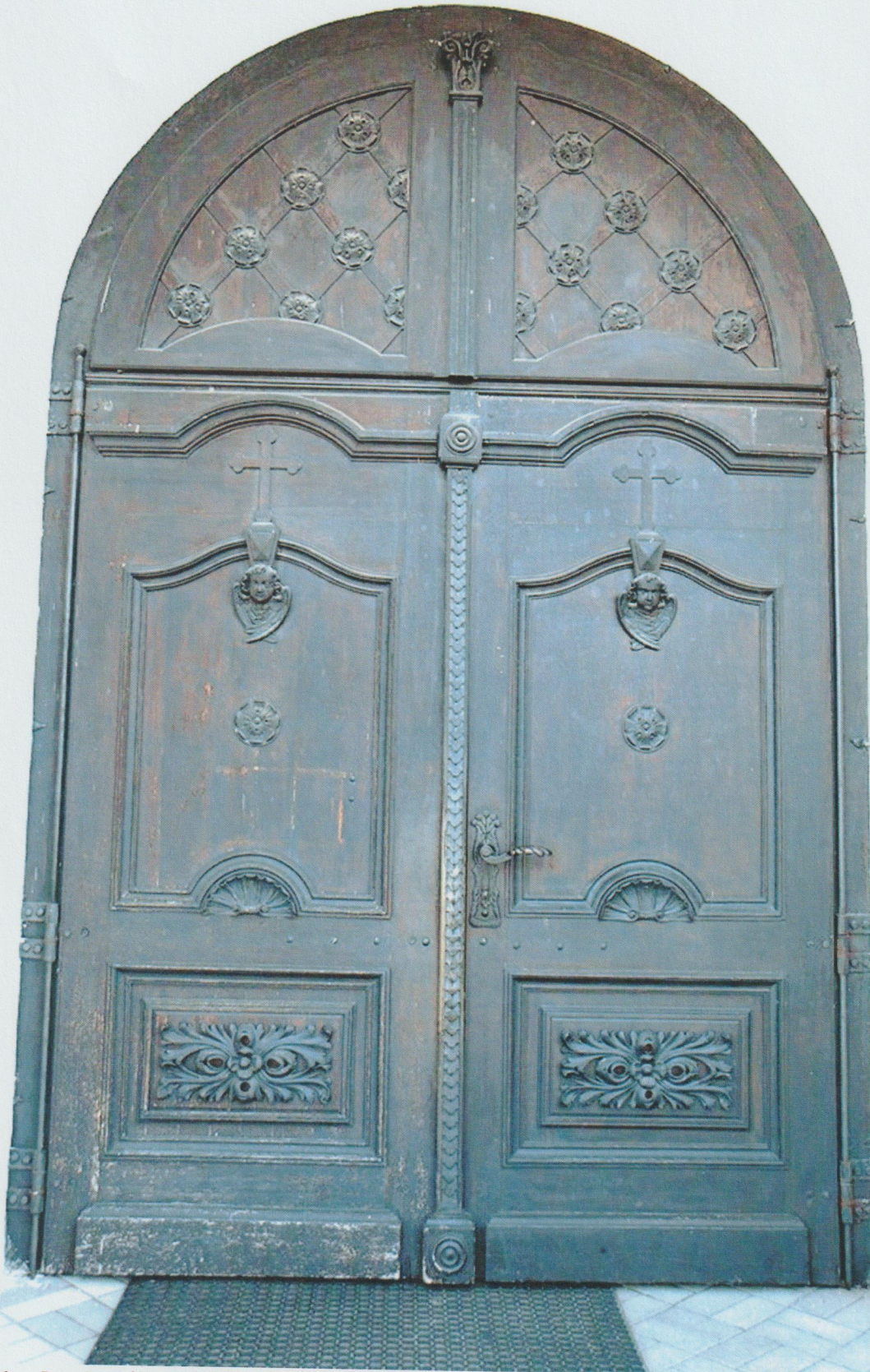
1. Drzwi wejściowe (główne) do kościoła parafialnego w ŁUSZOWICACH (1913-1919r.)
